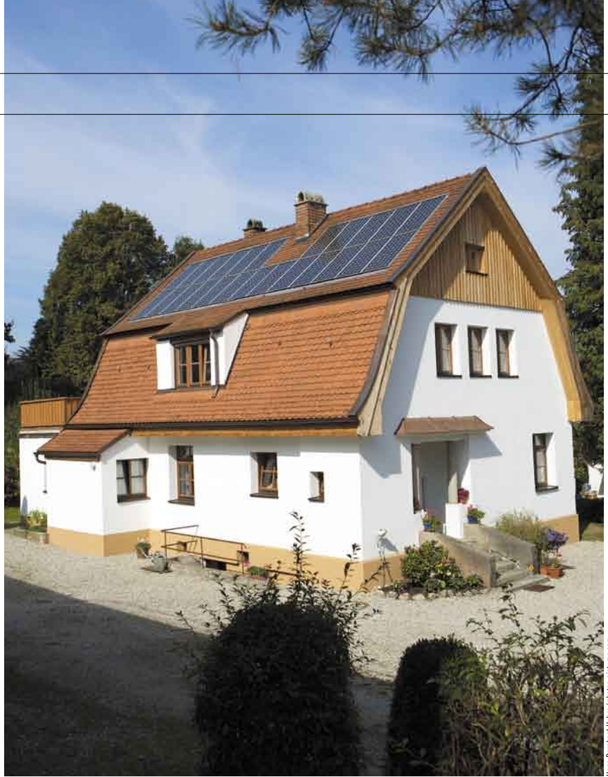
Neu konzipiert: In das Dach wurde eine wassergekühlte Photovoltaikanlage integriert. Das erwärmte Wasser dient zur Heizungsunterstützung. Unter dem Kies im Hof liegen die Erdregister einer Wärmepumpe.
